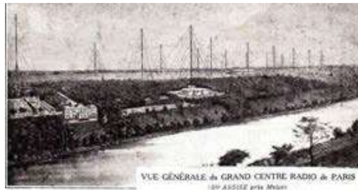
VUE GÉNÉRALE du GRAND CENTRE RADIO de PARIS par ASSISE près Melun Station pour le Service Intercontinental : 3 alternans S.F.R. à haute fréquence de 200 Kws approx. 36 pylônes S.F.R. de 210 mètres. Station pour le Service Européen : 4 alternans S.F.R. à haute fréquence de 25 Kws approx. 1 pylône S.F.R. de 250 mètres. + 2 postes à valves de 10 Kws.
