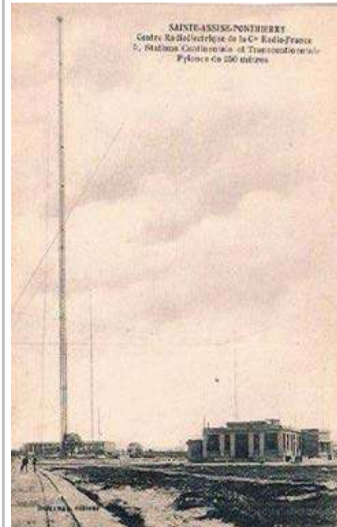
VUE GÉNÉRALE du GRAND CENTRE RADIO de PARIS par ASSISE près Melun Station pour le Service Intercontinental : 3 alternans S.F.R. à haute fréquence de 200 Kws approx. 36 pylônes S.F.R. de 210 mètres. Station pour le Service Européen : 4 alternans S.F.R. à haute fréquence de 25 Kws approx. 1 pylône S.F.R. de 250 mètres. + 2 postes à valves de 10 Kws.
