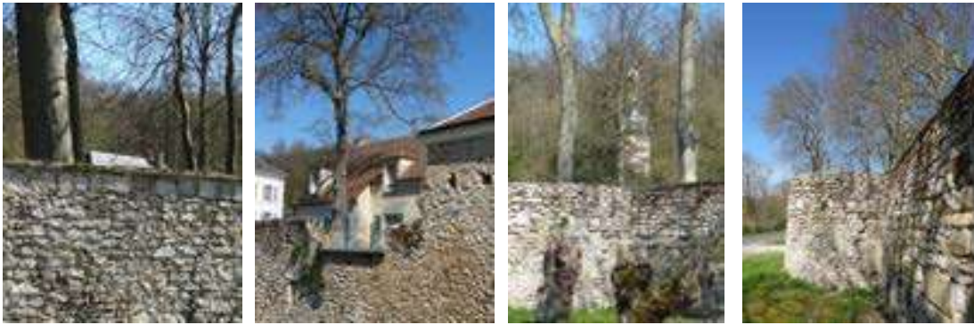
Site classé : Rue Croix Croix Fontaine – Murs – clôtures - portails
