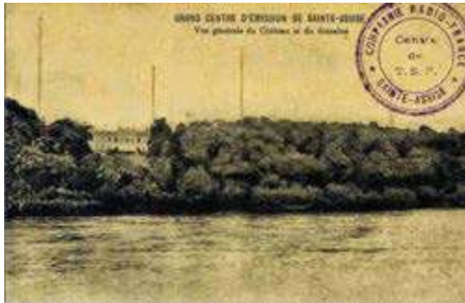
VUE GÉNÉRALE du GRAND CENTRE RADIO de PARIS par ASSISE près Melun Station pour le Service Intercontinental : 3 alternans S.F.R. à haute fréquence de 200 Kws approx. 36 pylônes S.F.R. de 210 mètres. Station pour le Service Européen : 4 alternans S.F.R. à haute fréquence de 25 Kws approx. 1 pylône S.F.R. de 250 mètres. + 2 postes à valves de 10 Kws.
