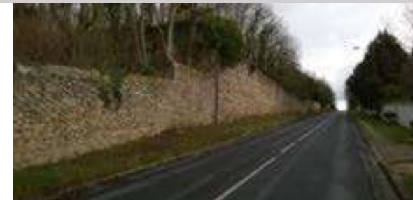
Route de nandy ( mur de cloture de Croix Fontaine)
