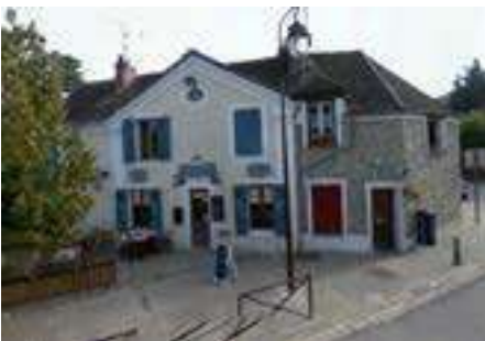
Place crée et placette induite du centre village favorable à la pérennité des commerces
